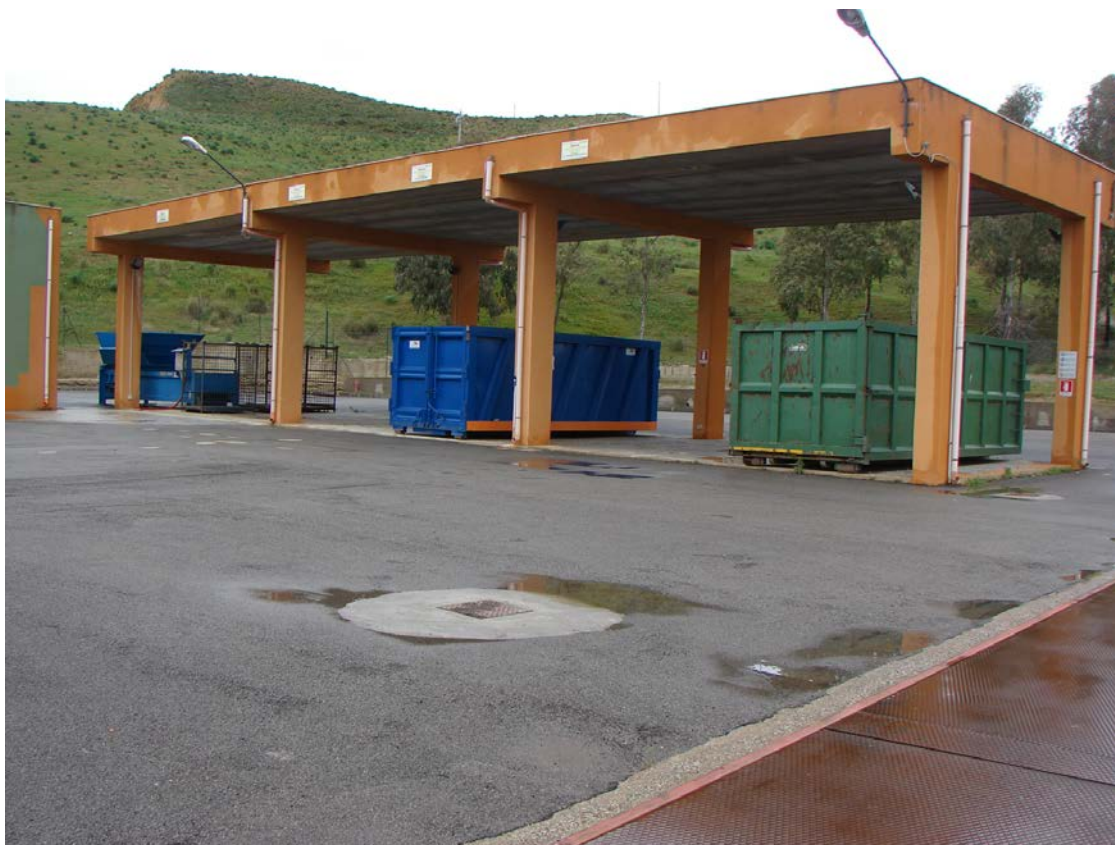
Vista della tettoia interna
